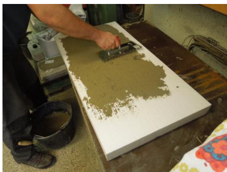
Obr. 1. Nanášení základní vrstvy s PP vlákny
