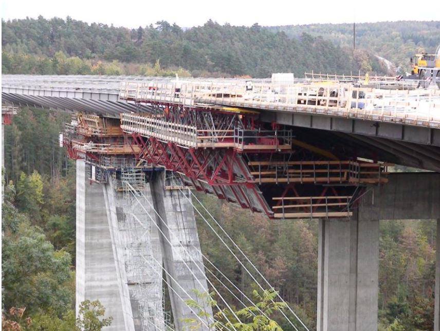
Obr. 1 – Výstavba mostu Lochkov na úseku 514 obchvatu Prahy
