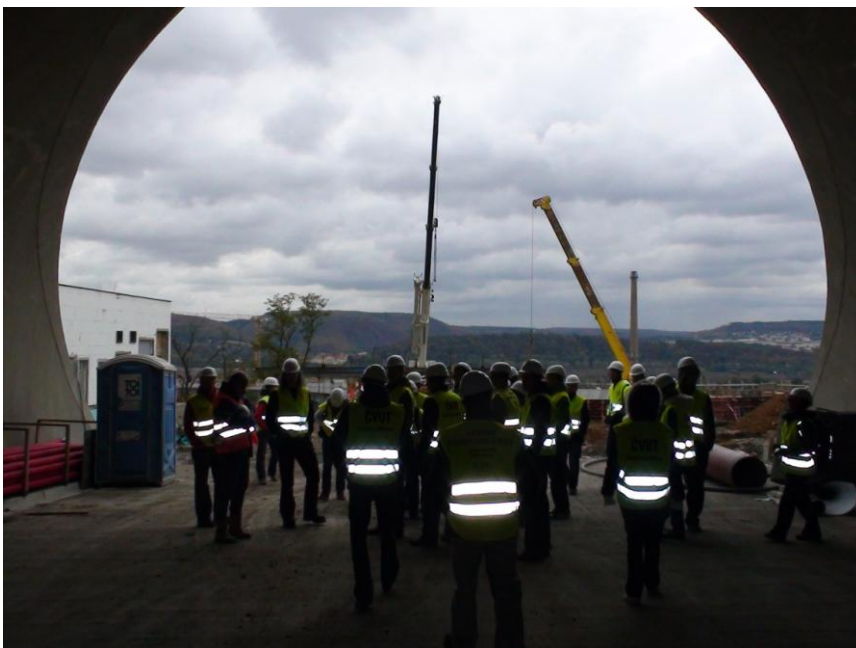
Obr. 2 – Výstavba tunelu Lochkov- Radotín na úseku 514 obchvatu Prahy
