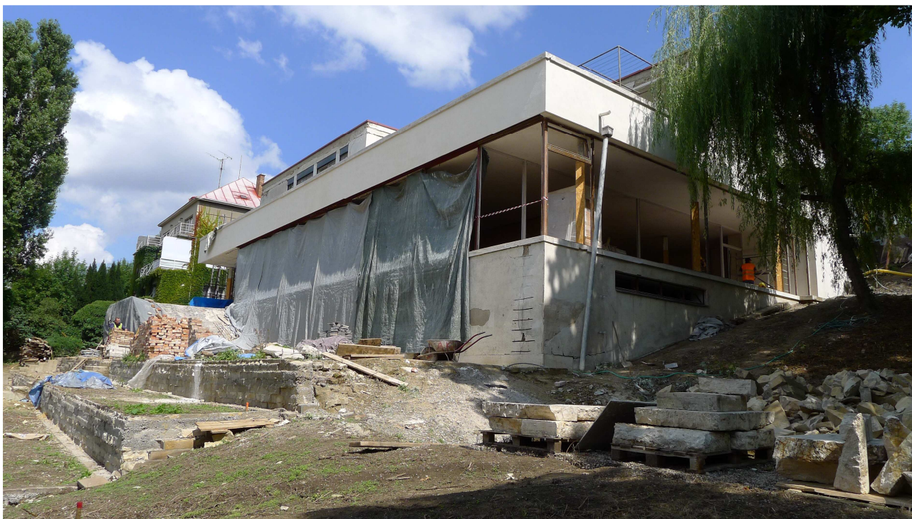
Vila Tugendhat v průběhu obnovy. Foto srpen 2011
