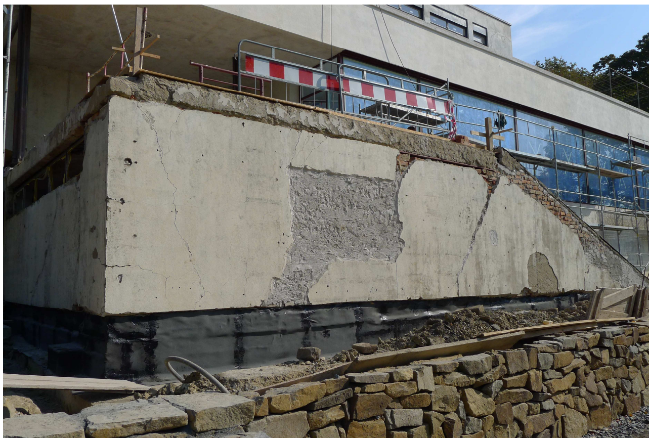
Tugendhat, detail vyzdívky schodiště do zahrady po zpětném transferu původních omítek
